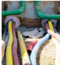
Hausanschluss im Rohrgraben
